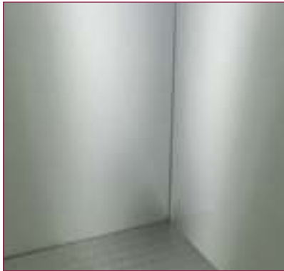
Wanddeckschicht in Edelstahl 240 Korn geschliffen
