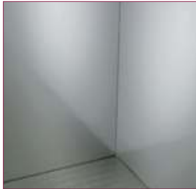
Wanddeckschicht in Edelstahl Walzblank 2B
