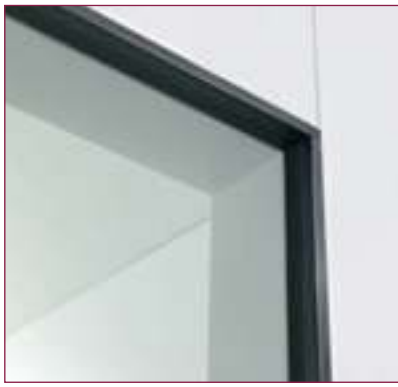
Türleibung mit einem Kälteunterbrecherprofil aus Kunststoff
