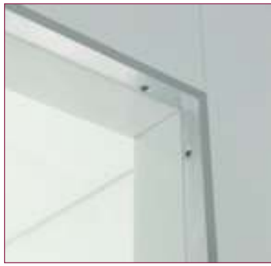
Bei Tiefkühlzellen standardmäßig mit einer Rahmenheizung ausgestattet
